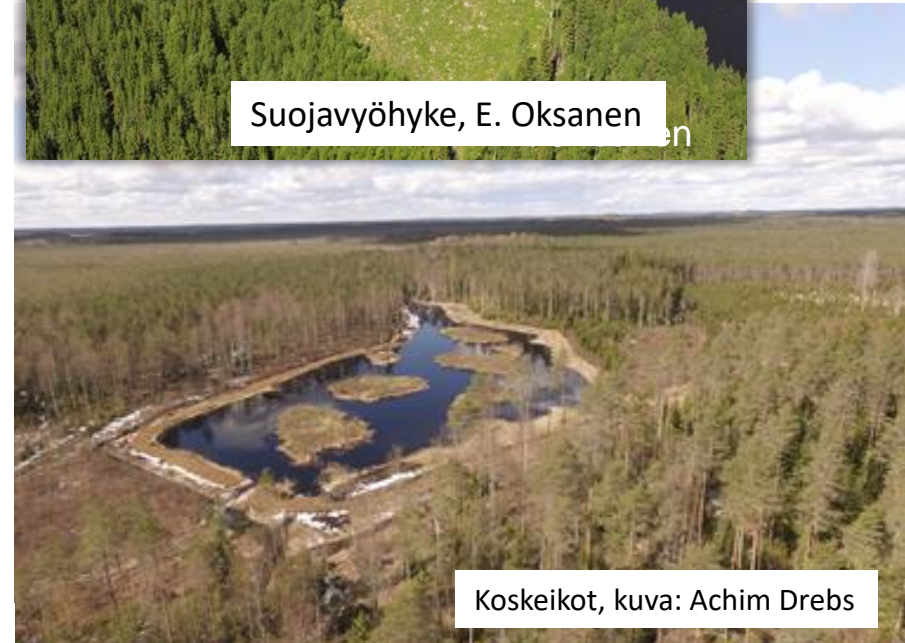
Putkipato+ laskeutusallas, kuva L. Ukonmaanaho
